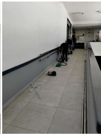
Pintura e instalação de corrimão na rampa de acesso
