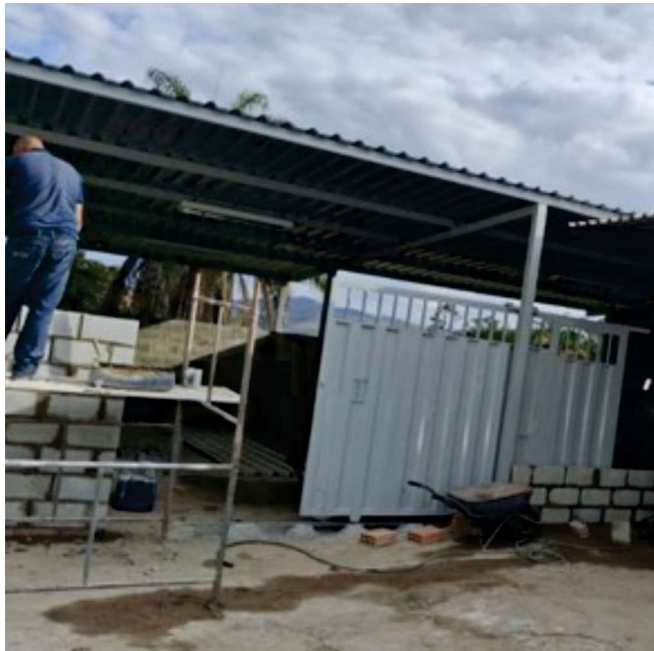
Ampliação e substituição do antigo telhado do setor de manutenção
