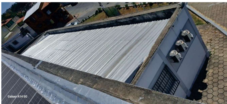
Substituição de calha
